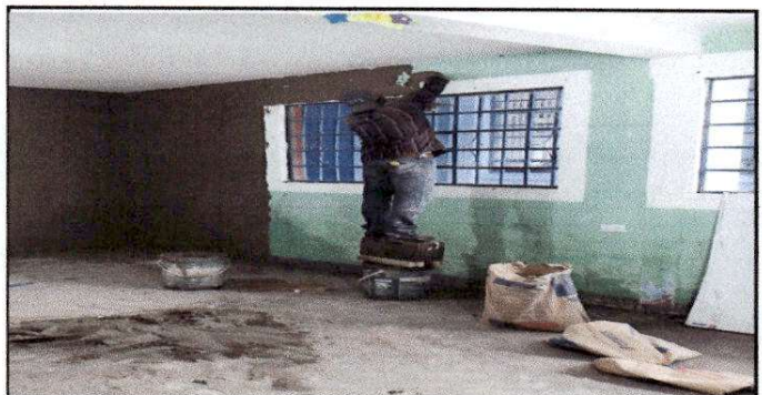
Foto 6. En esta fotografía se evidencian los trabajos realizados de los 95 metros cuadrados del repello de dos aulas en la parte interior del edificio escolar.
