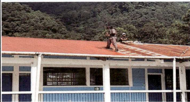
Foto 1. En esta fotografía se observa el trabajo que se está realizando de los 525 metros cuadrados, del pintado del techo de lamina del establecimiento educativo.
