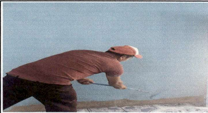
Foto 3. En esta fotografía se observa el pintado de los 95 metros cuadrados en la parte interior de las paredes, de dos aulas del edificio escolar.
