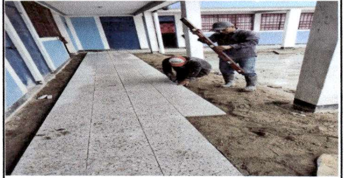
Foto 2. En esta fotografía se observa el trabajo que se está realizando de los 110 metros cuadrados, sobre la sustitución del piso de torta de cemento por piso de granito, en los corredores del establecimiento educativo.
